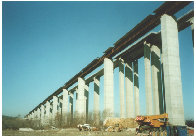
Fig.1: view of the Viaduct “Stura di Demonte”
